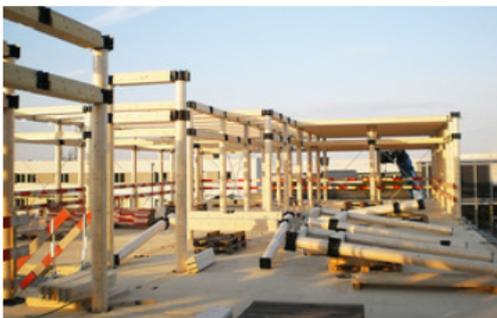
Das Holzstecksystem von Lukas Lang Building Technologies lässt sich in kürzester Zeit aufbauen und kann ebenso leicht wieder rückgebaut und wiederverwendet werden.
