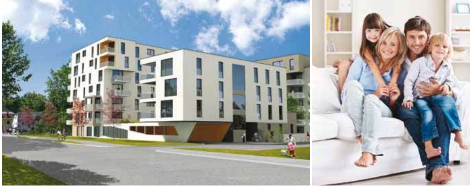
Am ehemaligen Betriebsareal der Telekom entstehen gerade 148 Wohneinheiten.
