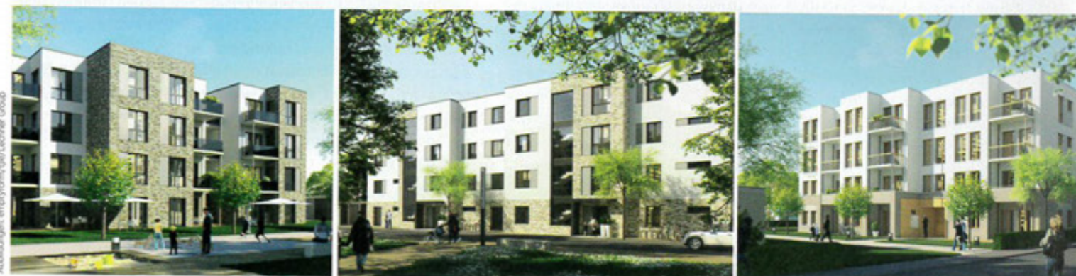
Module aus Stahlbeton: Das Konzept der Lechner Immobilien Development GmbH mit Planquadrat Elfers Geskes Krämer PartG Architekten und Stadtplaner greift eine klassische städtische Fassade mit einer optisch überhöhten Sockelzone auf. Die Grundrisse der Wohnungen sind zusammenschaltbar.
