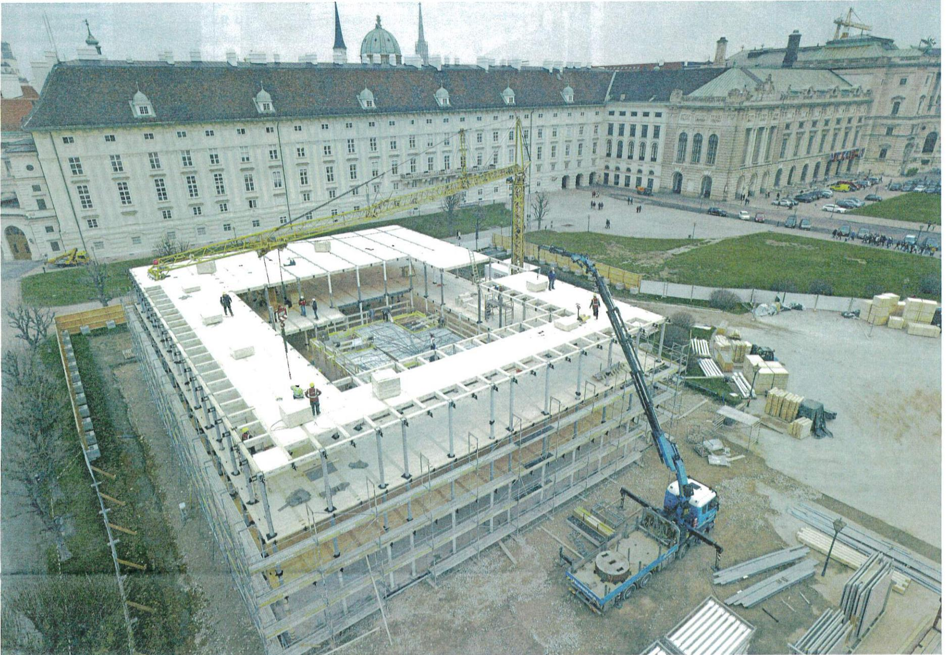
Building Technologies: Bau auf Zeit! Das temporäre Bürogebäude am Wiener Heldenplatz als Ausweichquartier für das österreichische Parlament, als standardisiertes Holz-Baukasten-System errichtet, ermöglicht den raschen Aufbau und eine ebensolche Demontage. FOTO: LUKAS LANG
