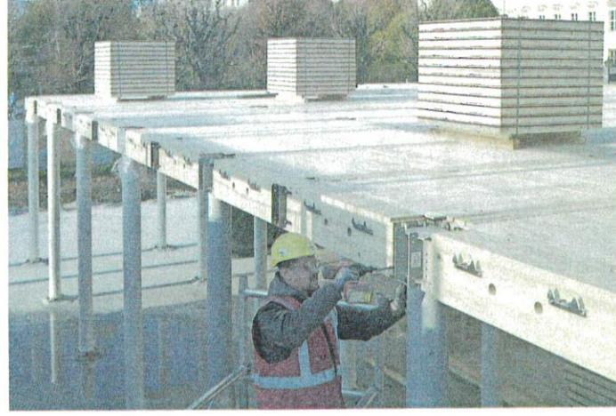
Temporäres Parlamentsgebäude. Vorgefertigte Bauteile werden auf der Baustelle mit geringem Technikaufwand verschraubt und justiert. FOTO: LUKAS LANG
