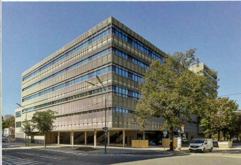
Abb 3 (oben) Abb 4 (unten) Messestraße II, 1020 Wien (2018)
