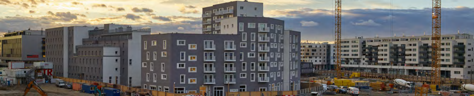
Fotos Baufortschritt/photos construction progress © Kurt Hörbst
