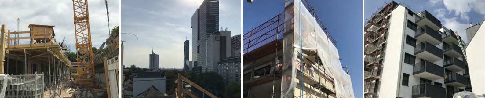
Fotos Baufortschritt/photos construction progress © WGA ZT GmbH
