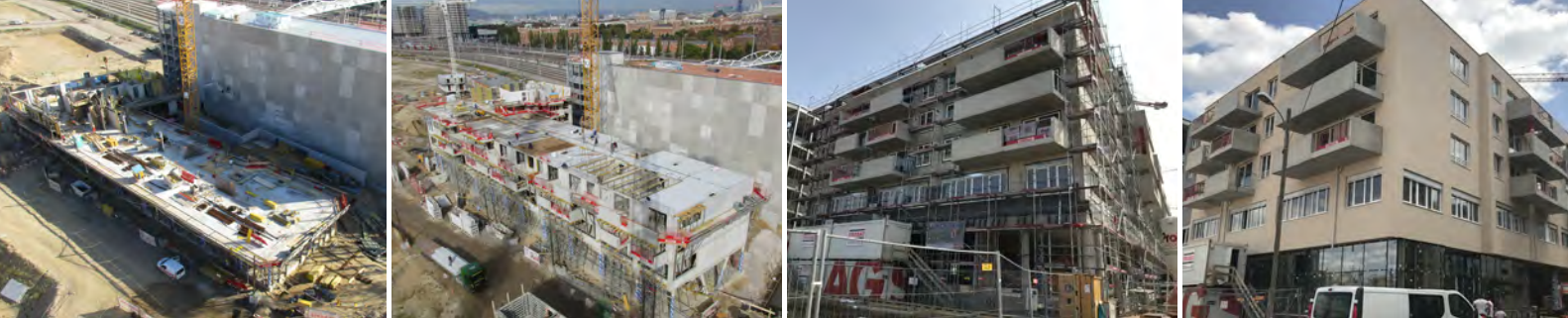
Fotos Baufortschritt/photos construction progress © WGA ZT GmbH
