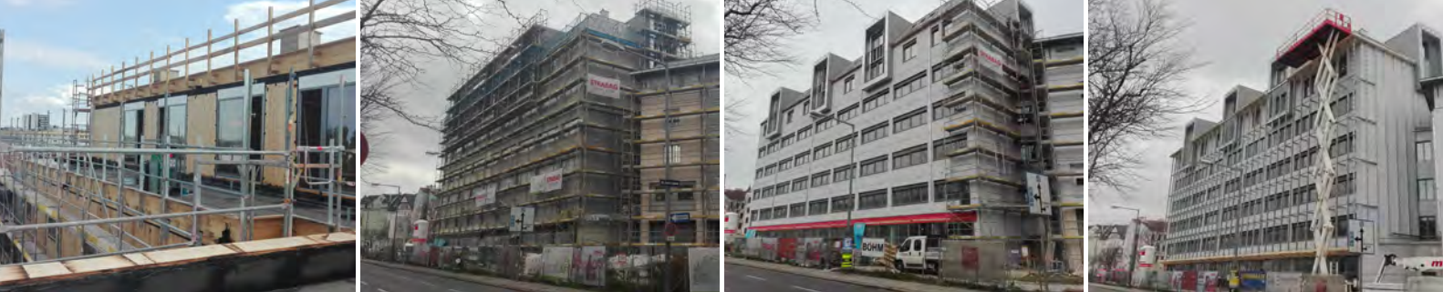
Fotos Baufortschritt/photos construction progress © WGA ZT GmbH
