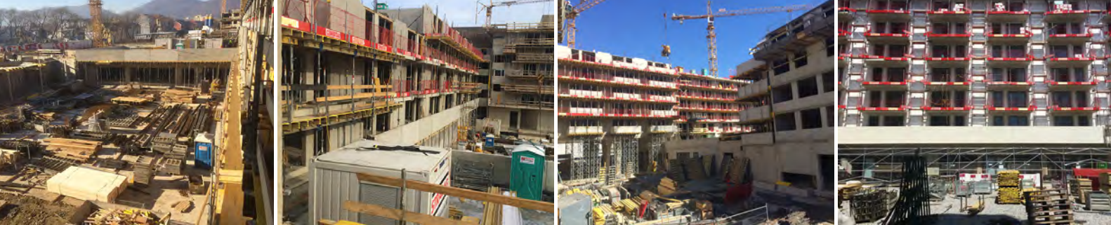
Fotos Baufortschritt/photos construction progress © WGA ZT GmbH
