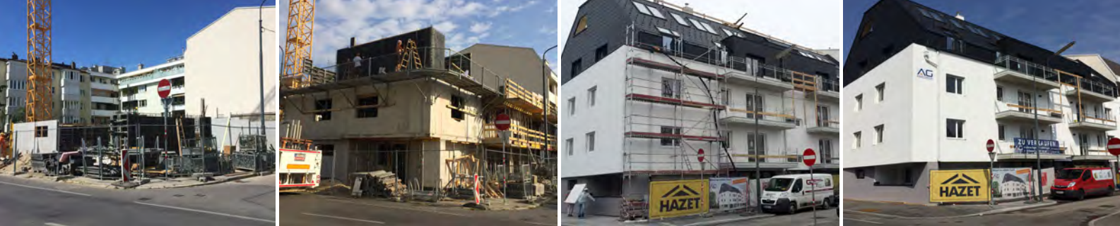
Fotos Baufortschritt/photos construction progress © WGA ZT GmbH
