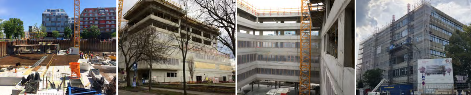
Fotos Baufortschritt/photos construction progress © WGA ZT GmbH
