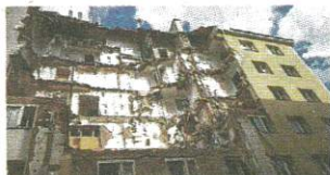
2019 wurde das Haus nach der Gasexplosion abgerissen.
