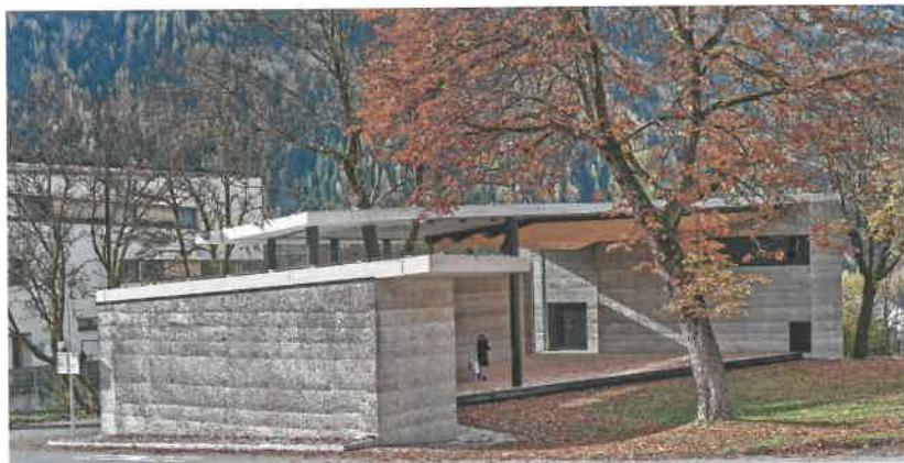
PAVILLON UMHAUSEN Ebenfalls einig zeigte sich die Jury beim Anerkennungspreis für den Pavillon in Tirol. Architektur: Armin Neurauder ZT GmbH; Beton: Auer Bau GmbH; Ausführung: Arge Auer & Auer Bau GmbH; Bauherr: Gemeinde Umhausen.
