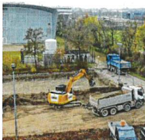
Für den Neubau der Biologen auf dem Unicampus sind die ersten Bagger aufgeföhren. Foto: Michael Hochgemuth
