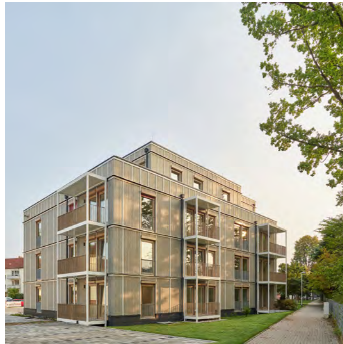
STEUBENSTRASSE 161-194, LANGEN / © Kurt Hörbst
