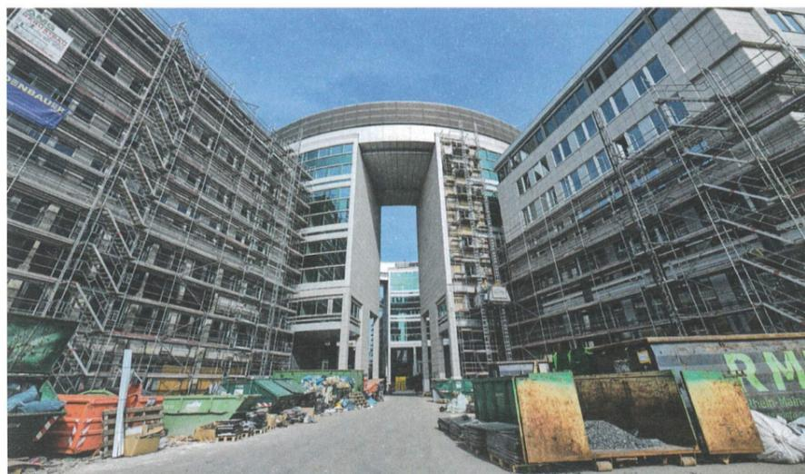
Ganz im Sinne der Kreislaufwirtschaft werden die ausgebauten Fensterelemente noch vor Ort in Containern nach den Wertstoffen Aluminium, Glas und EPDM-Dichtungen getrennt und dann in die entsprechenden Recyclingwerke transportiert.
