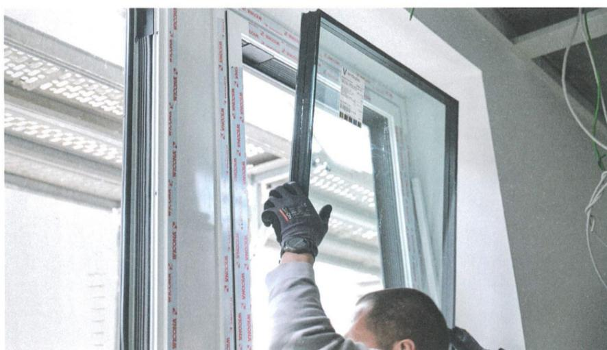
Das Konzept des Sanierungsfensters ist intelligent wie einfach: Es werden ausschließlich die Füllungs- und Öffnungselemente der alten Fenster ausgetauscht.
