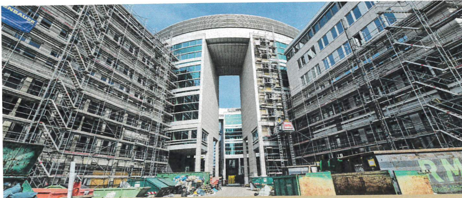
Die ausgebauten Fensterelemente werden vor Ort in Container nach den Wertstoffen Aluminium, Glas und EPDM-Dichtungen getrennt und dann in die entsprechenden Recyclingwerke transportiert
