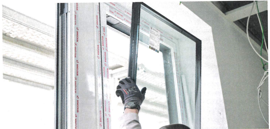
Das Konzept des Sanierungsfensters ist so intelligent wie einfach: Es werden ausschließlich die Füllungs- und Öffnungselemente der alten Fenster ausgetauscht
