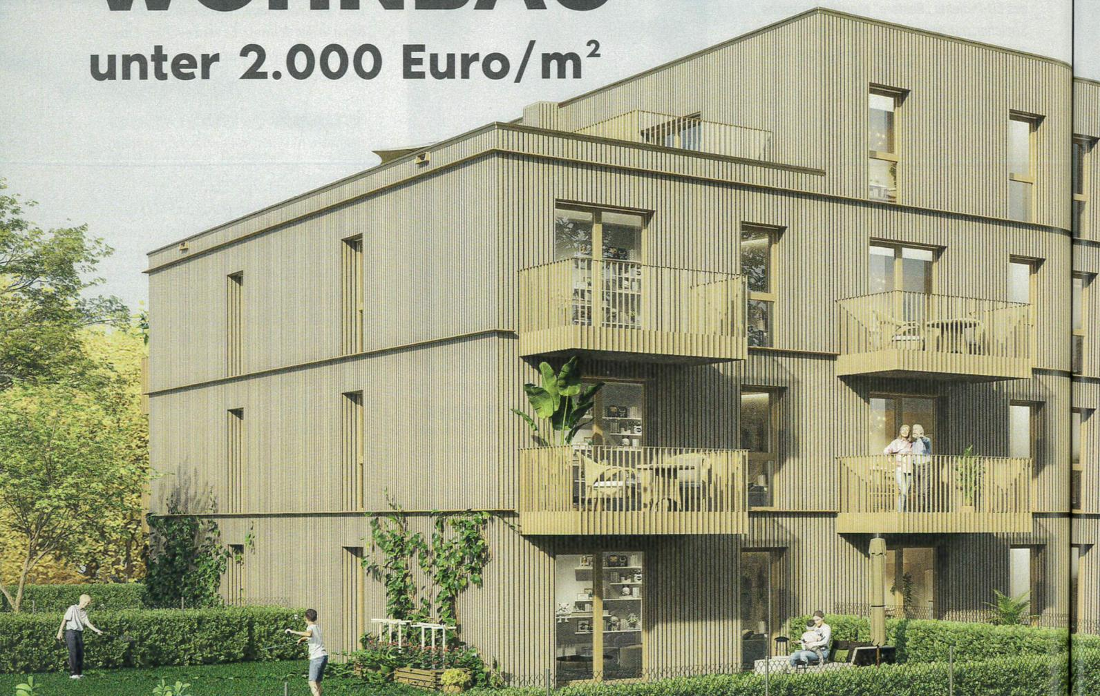
Die Strabag bietet mit Tetriqx eine modulare Wohnbaulösung ab 1.950 Euro pro m<sup>2</sup>. Ein industriell vorgefertigtes Baukastensystem verkürzt die Bauzeit und spart Kosten. Gebaut wird in Holz-Hybrid-Bauweise.
