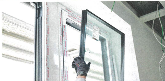
Einsetzen des Adapterrahmens im Rahmen der Revitalisierung der Bandfenster-Fassade
