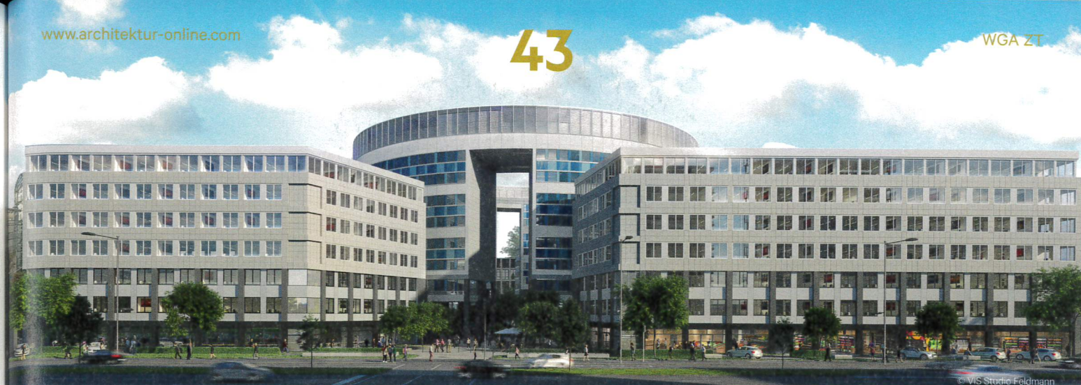
Das Omega-Haus in Offenbach am Main, eine Architekturikone der 1990er-Jahre, wird von der WGA ZT GmbH umfassend saniert und in ein EGB 55-konformes Multi-Tenant-Gebäude mit angestrebter LEED-Gold-Zertifizierung überführt.
